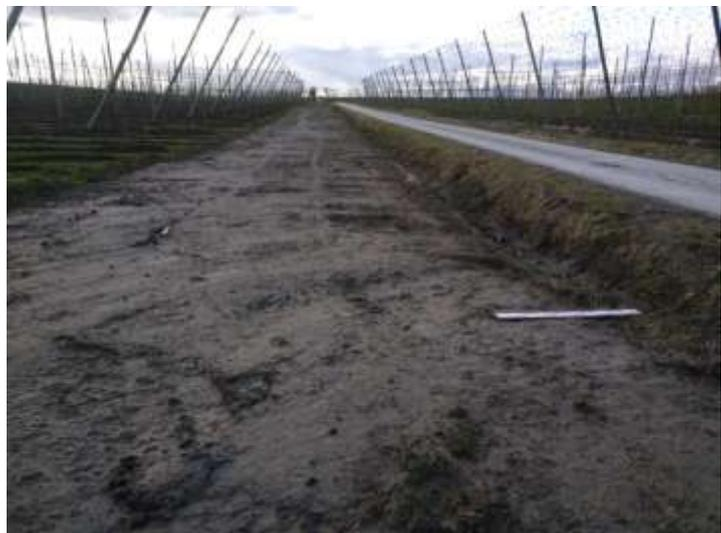
*Grabenaufweitung im südlichen Einzugsgebiet: Ein flacher Restgraben zur Straßenentwässerung bei normalen Niederschlägen bleibt. Die feldseitige Schulter wurde abgetragen, damit sich Starkregenabflüsse im Vorgewende der Hopfengärten ausbreiten können. An manchen Stellen ist die Abtragung noch schwach, Nacharbeit ist dort zu empfehlen.*
