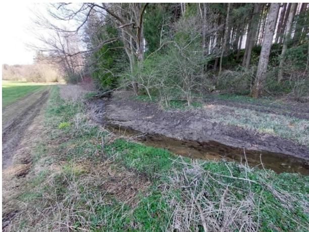
Bild 1: Aufweitung am Pickenbach, Überflutung nur bei Wasserständen über der Mittelwasserlinie; © Amt für Ländliche Entwicklung Oberbayern
