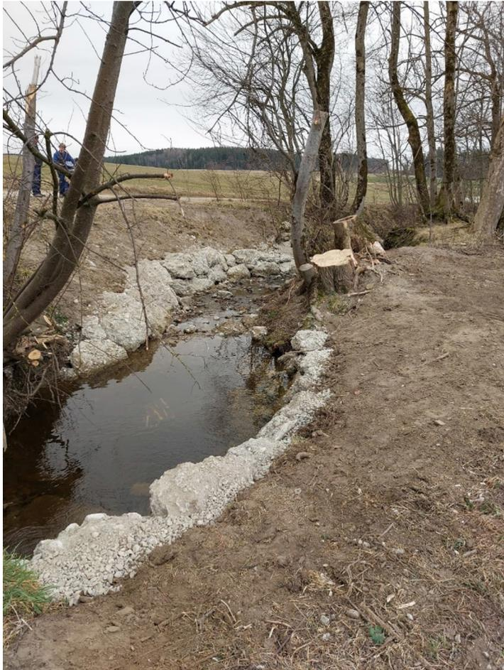
Bild 8: neue bauliche Sicherung durch Natursteine östlich der Überfahrt; © Amt für Ländliche Entwicklung Oberbayern
