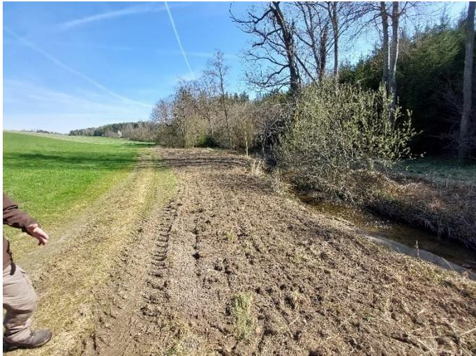
Bild 3: Aufbringen des Aufhubs zwischen Weg und Graben, Anlage einer Blühwiese; © Amt für Ländliche Entwicklung Oberbayern
