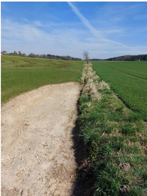
Bild 7: Aufweitung des Grabens vor der Verrohrung; © Amt für Ländliche Entwicklung Oberbayern
