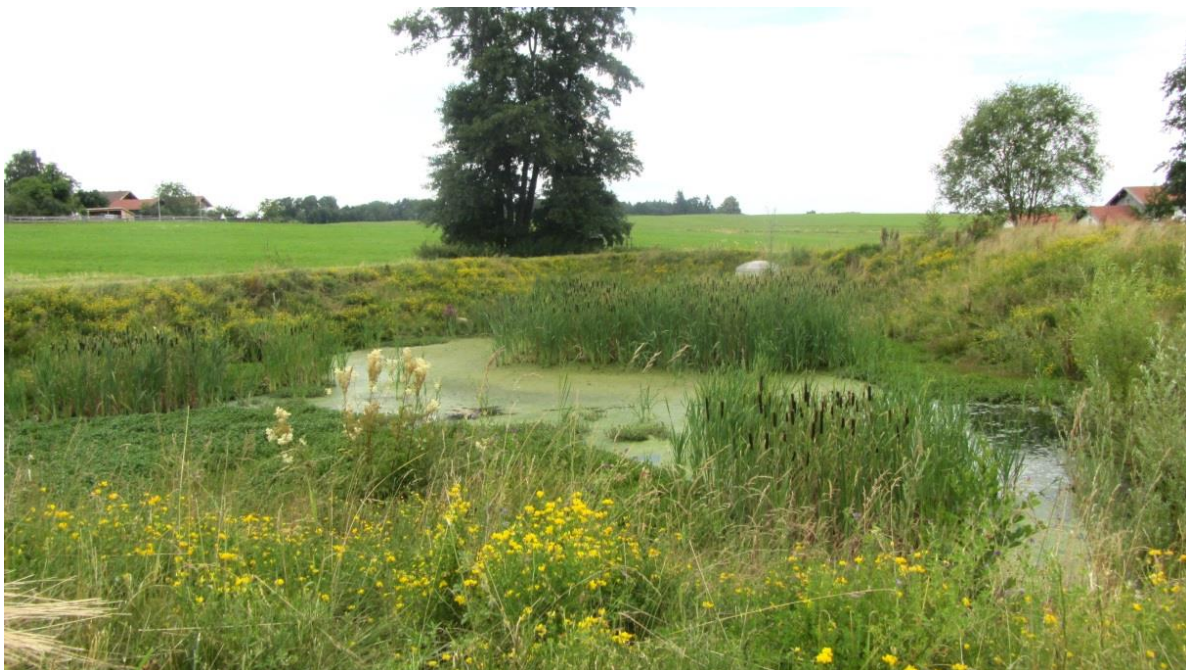
Beispiel eines ingenieurökologischen Absetz- und Rückhaltebeckens im boden:ständig-Projekt Waginger / Tachinginger See
