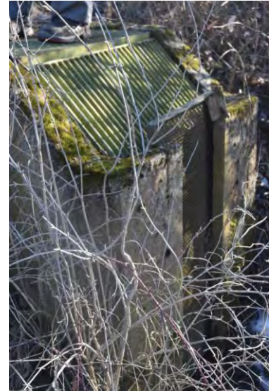
Einlaufbauwerk für den Grundablauf des bestehenden Beckens
