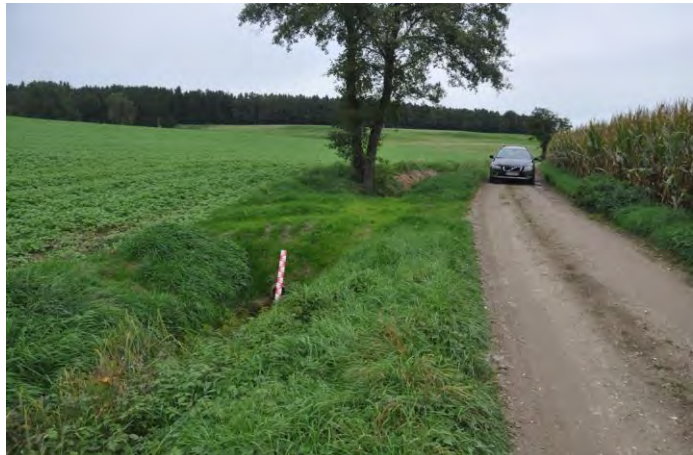
Ausgeführte Maßnahme am Mordgraben, Aufnahme 2019
