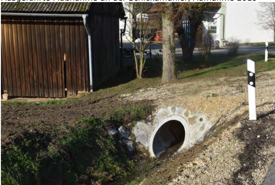
Ausgeführte Maßnahme an der Schickamühler, Aufnahme 2019
