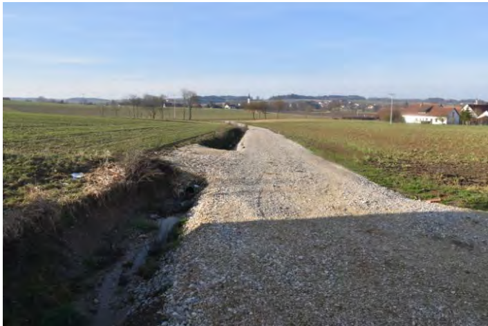
Seitliche Ableitung in Straßengraben, Aufnahme 2019
