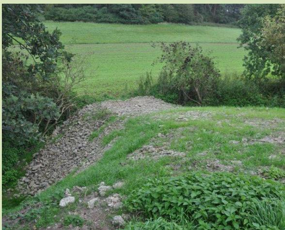
**Zwei Fliegen mit einer Klappe schlagen:** Gestaltung einer Hofzufahrt als gleichzeitige Rückhaltestruktur für aus der Fläche abfließendes Wasser (rechts).
