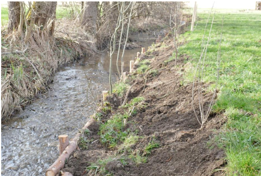
Abbildung 1: Grabenaufweitung mit Uferabflachung und neu gepflanzten Sträuchern
