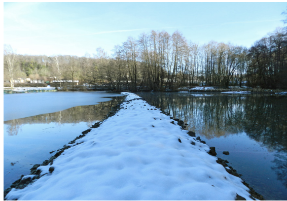
◆ Dammbauwerk im Waldsee bei Niedrigwasser, Januar 2018
