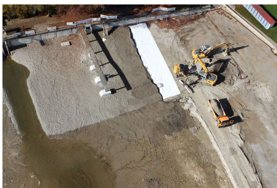
◆ Luftbild der Räumungsaktion 2013
