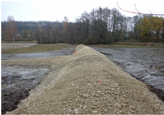
◆ Dammbauwerk im Waldsee nach der letzten Räumung, 2014
