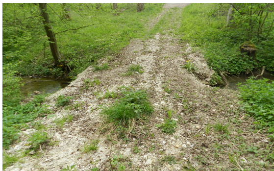
◆ Vorhandener Forstweg kann zu einem Dammbauwerk ausgebaut werden
