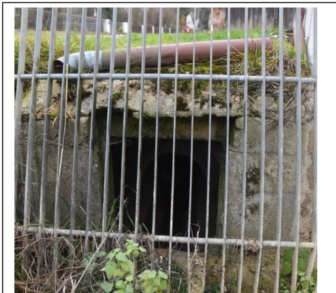
*Das Einzugsgebiet, das dieses Rohr an der Schulstraße in Weidorf entwässern soll, ist vier Mal so groß wie das Einzugsgebiet von Schönesberg, dessen tobende Wassermassen im Bild oben dokumentiert sind. Extremereignisse werden immer über den Straßenraum abfließen, aber es liegt auf der Hand, dass das abgebildete Rohr auch schon bei weit geringeren Niederschlägen überlastet ist.*
