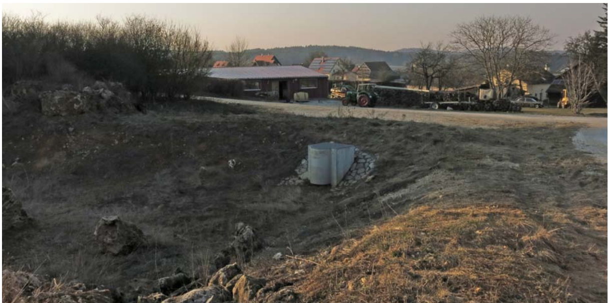
Gumpen als Sammelbecken für die Seitengräben
