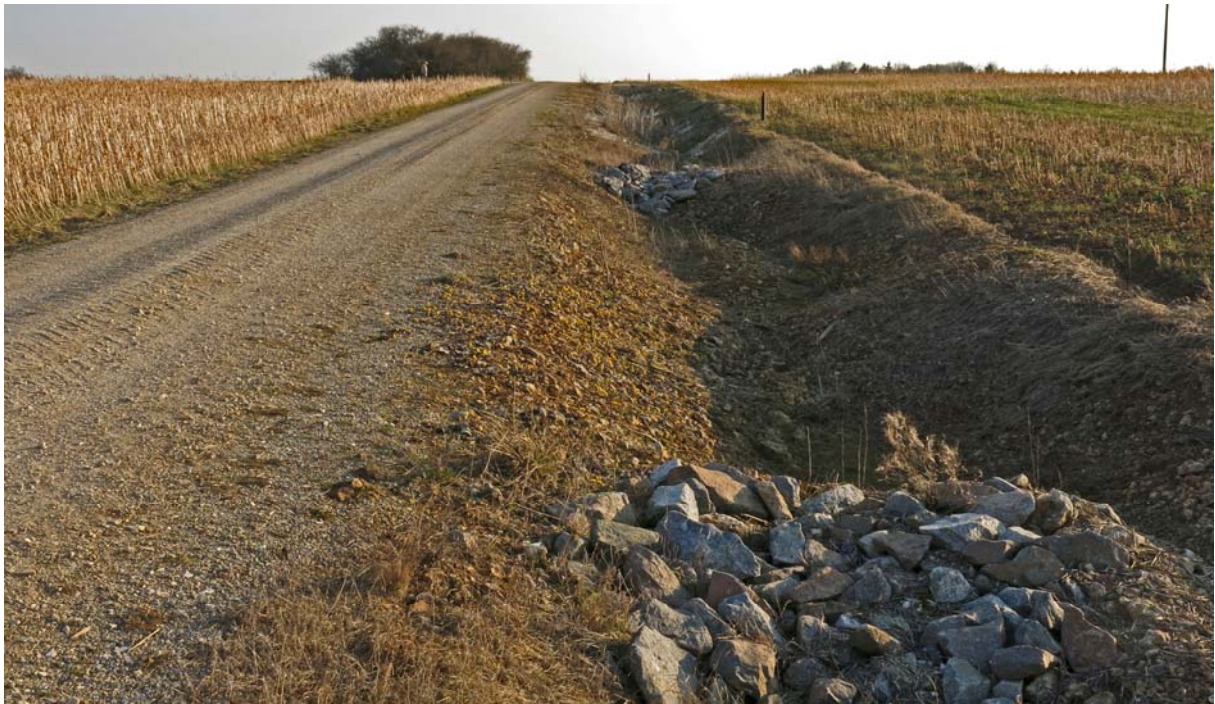
Seitengraben mit eingebauten Stauschwellen und mäandrierendem Lauf
