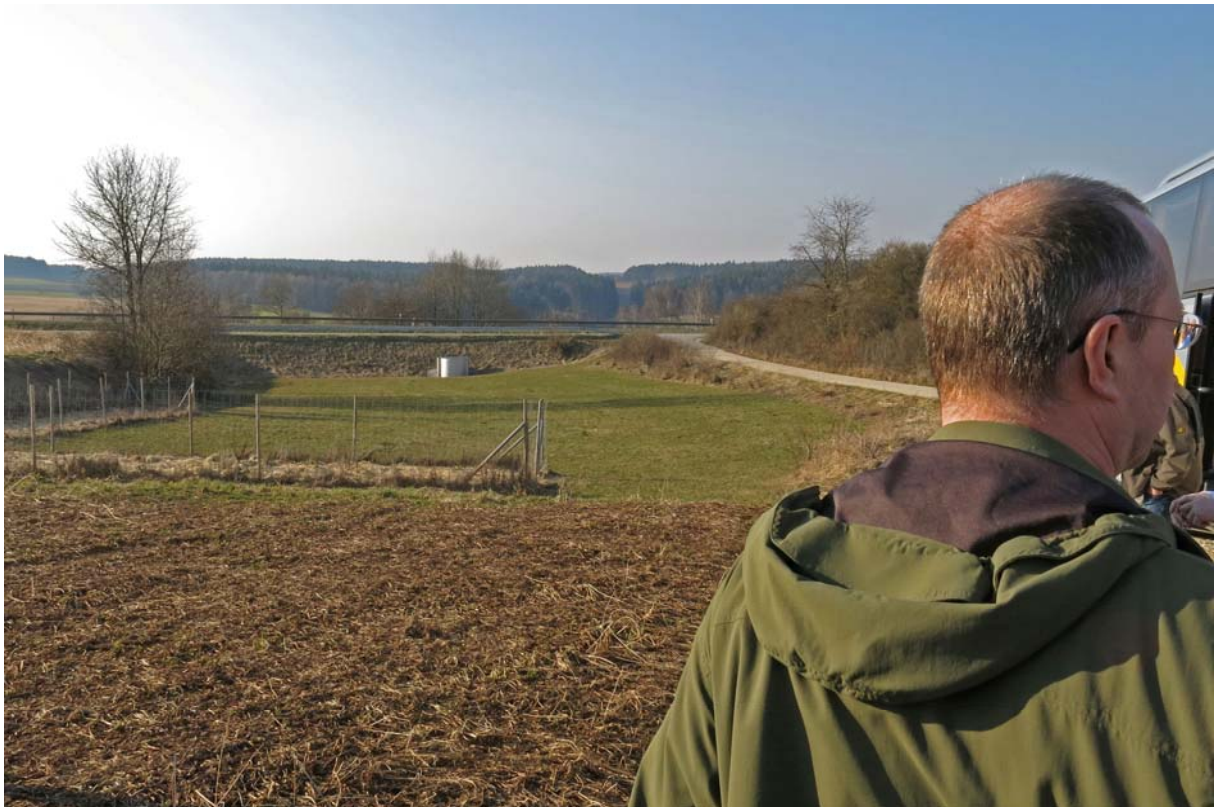
Bewirtschaftete Rückhaltemulde an der Staatsstrasse mit Ablaufbauwerk
