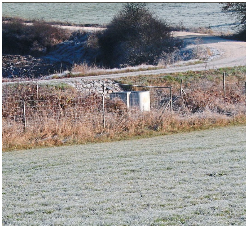
Einen so genannten Mönch (Bauwerk Bildmitte), ein geregelter Überlauf am Ende des Staubeckens, das zudem von einem Damm mit verstärktem Unterbau begrenzt wird, konnten die Teilnehmer in Kollersried bei Hemau besichtigen.
