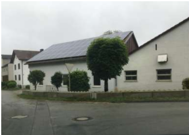
Unter dem Eindruck der Starkregen 2018 errichtete Sicherung durch Betonblöcke (Untertollbach, Haus Nr. 1)
