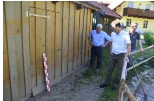
Hochwassermarken an einem Nebengebäude Morgenrothmühle 1, Juni 2019, im Vordergrund Dr. Joachim Hamberger, Leiter des AELF Abensberg (rechts) und 1. Bürgermeister Dr. Johann Bergermeier (links)
