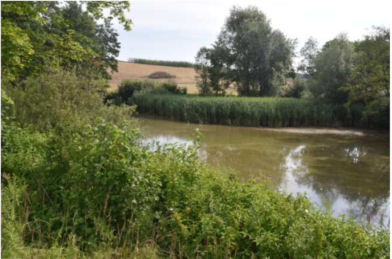
Das obere Rückhaltebecken Mitte Juli 2019.
