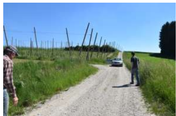
Am Rand der Gemeinde Wildenberg erfolgt der Abfluss etwa auf Höhe des abgestellten Fahrzeugs quer über den Weg und weiter über die talseitige Fl.-Nr. 384. Er soll in den bergseitigen Straßengraben in Richtung des Fotografen abgeleitet werden.
