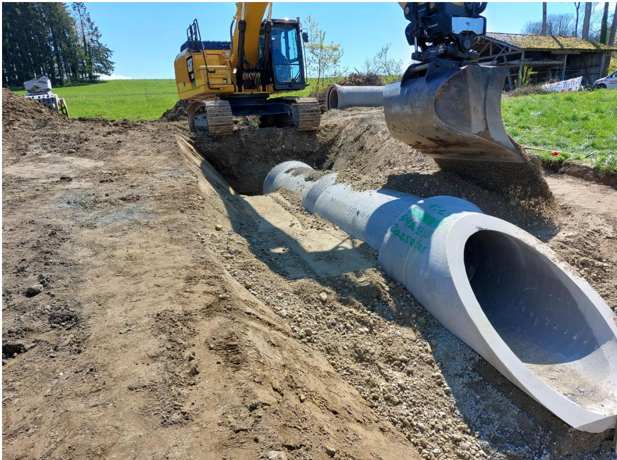
Bild 2: Einbau des neuen Straßendurchlasses
